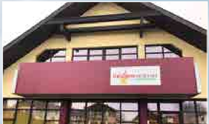
Bereichsfeuerwehrgebäude Sanierung und Erneuerung von Balkon und Glasgiebel
