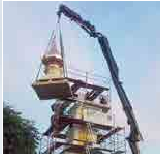
Sanierung Kapelle Gosdorf
