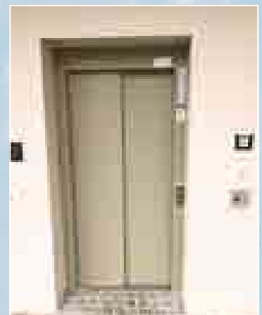
Neubau der Liftanlage
