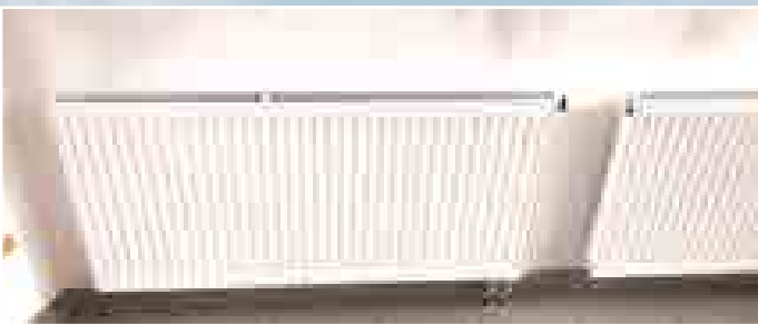
Ehemaliges Gemeindeamt & Feuerwehrrüsthaus Eichfeld: Erneuerung Heizkörper & Verteiler
