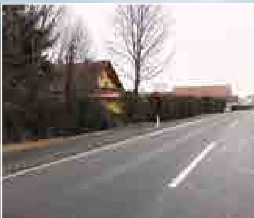
Gehwegerrichtung an der L208 (Thöni)
