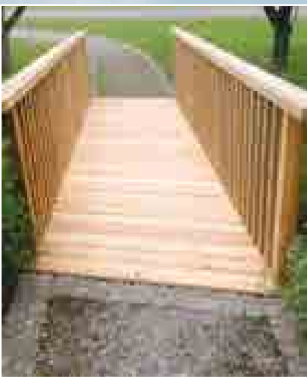
Dorfplatz Gosdorf – Erneuerung der Fußgängerbrücke
