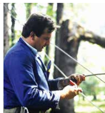
Instandsetzungsarbeiten durch das EVU Mureck
