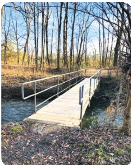
Sanierung der Brücke zwischen Kläranlage Gosdorf und Radweg R2
