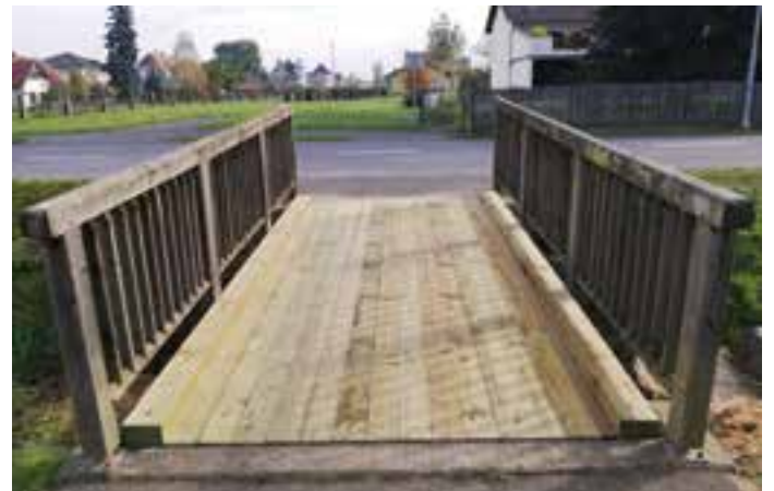
Brücke Friedhof Mureck
