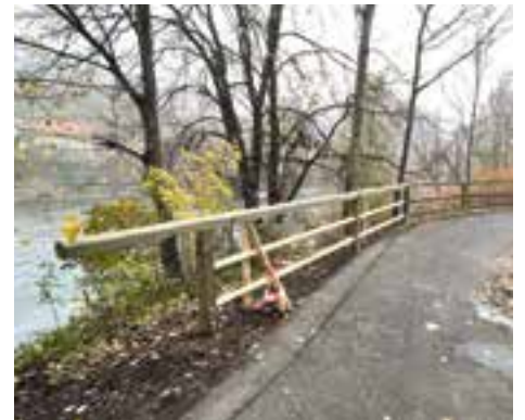
R2 nach ARA Mureck
