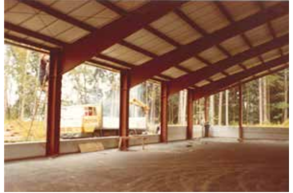
1980 – Bau der Tennishalle
