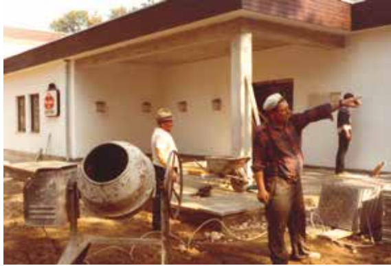
1980 – Bau der Tennishalle
