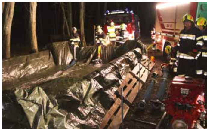
Bei der Übung wurde mit Paletten und einer Folie ein provisorisches Wasserbecken zur Versorgung mit Löschwasser errichtet.
