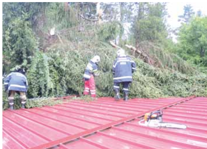
Aufarbeitung von Sturmschäden im Stadtgebiet Mureck
