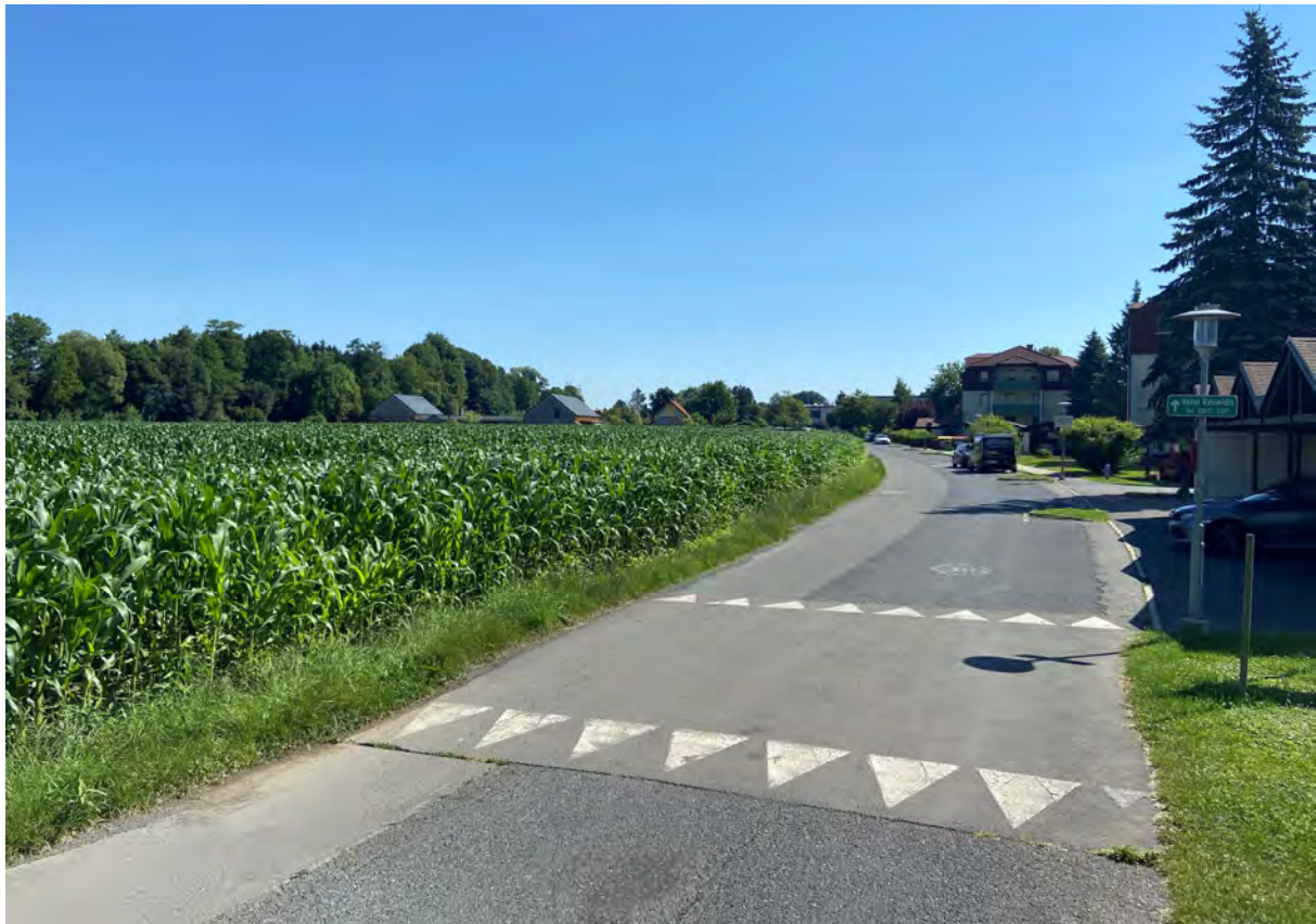
Abb. 2: Blick aus Südwesten in den Straßenraum der Süßenberger Straße auf Höhe des Baulanderweiterungsbereich
